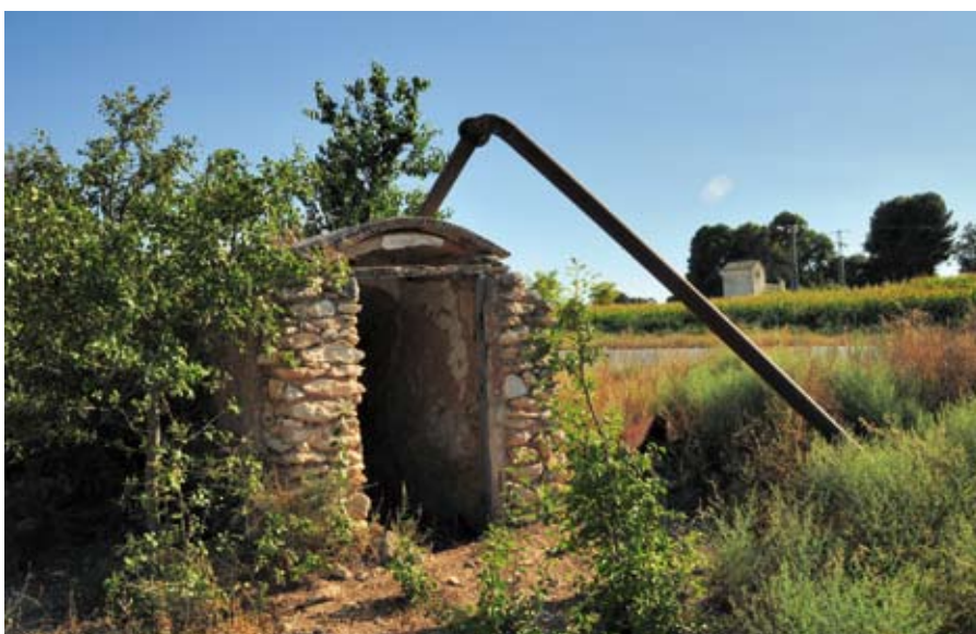
Pozos alrededor del parque, perforando el acuífero 23, sacando por la tubería miles de litros de agua, sin control.
